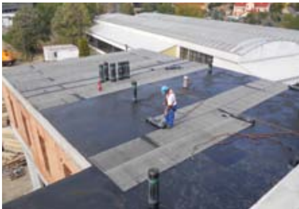
Az első réteg Plana P 4mm-es lemez fektetése.
