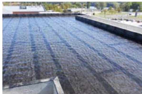
Az elkészült vízszigetelés árasztásos minőségellenőrzése.
