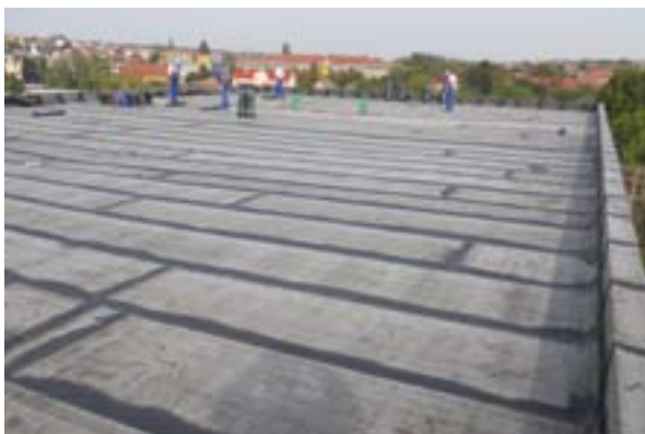
A második réteg Plana P 4mm-es lemez fektetése.
