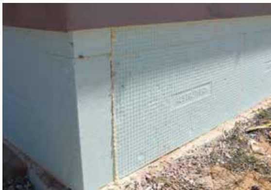
Az EXPERT® FIX felhasználásával készült lábazati hőszigetelés (fotó: Austrotherm Kft.)
