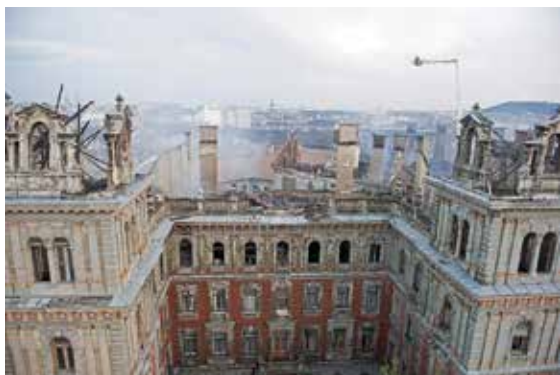
3. ábra: Balusztrádós főpárkány a tüzeset után.
